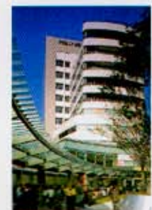
6階プラザよりハリウッドビューティプラザを見る
